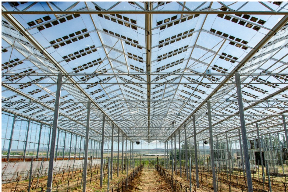
Abbildung 22. In die Glasabdeckung eines Gewächshauses eingebettete PV-Anlage [5.12].
